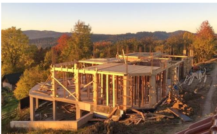
Fase 2 de la construcción del Centro de Luz, completando la estructura y el techo de madera.
